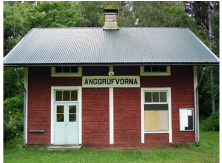
Ånggruvans stationsbyggnad fyra km norr om Filipstad.
