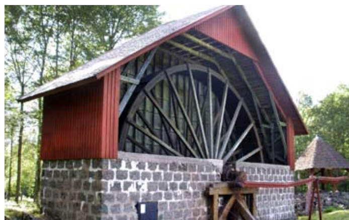
Tabergs konsthjul, Nordmark använder vatten som drivkraft.
